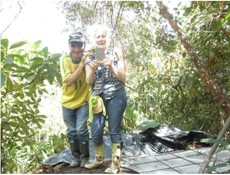
Nora Piedrahita y Uriel Gil empezando la construcción de la Gruta.
